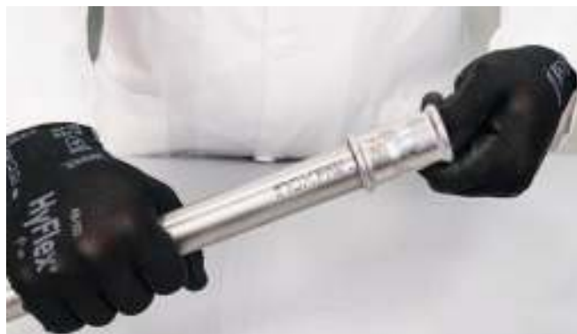
Рис. 31. Вставка трубы в пресс-фитинг.
